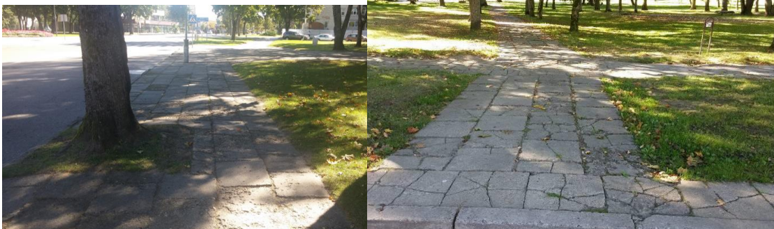
1.1.1 pav. Prastos būklės pėsčiųjų infrastruktūra greta Jaunimo g. ir B. Sruogos g.
