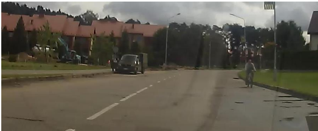
1.1.3 pav. Ne gatvės lygyje įrengti dviračių takai Šaltinis: Sudaryta autorių
