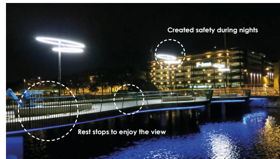
MALMO, SWEDEN KAPTENSBRON BRIDGE:
