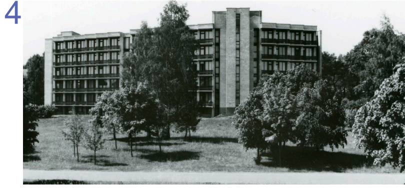
"Spalis" sanatorium. Source: Limis.lt
