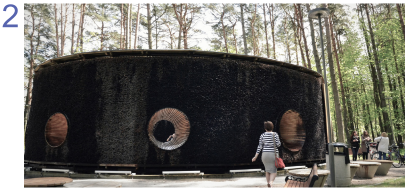
Mineral water evaporation tower "Druskupis". Source: KAUNAS.KASVYKSTA.LT
